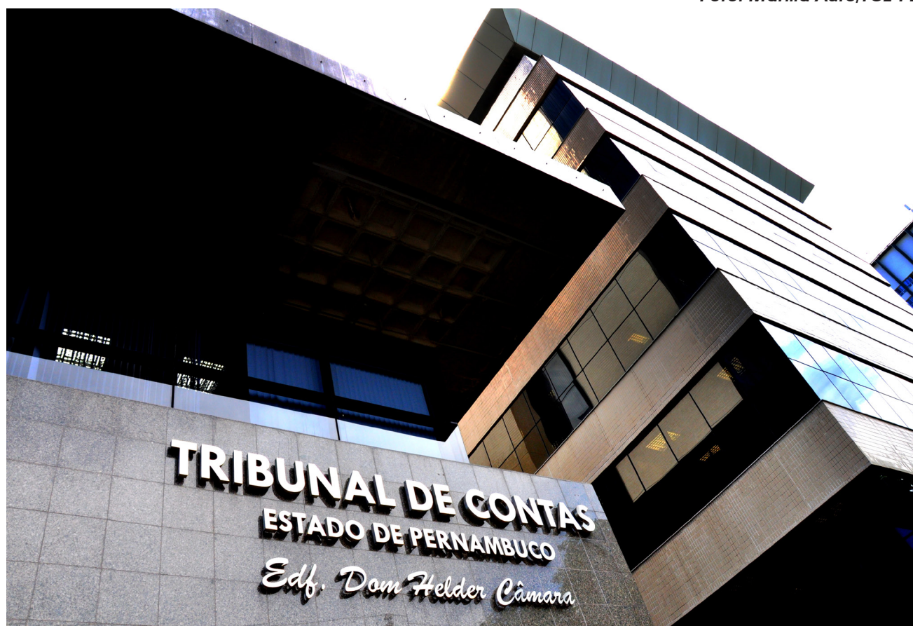
Imagem da fachada do Tribunal de Contas do Estado de Pernambuco
